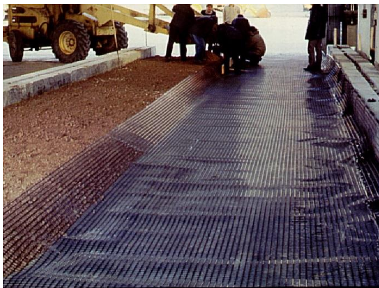
Figure 5. Préparation de la zone de test
