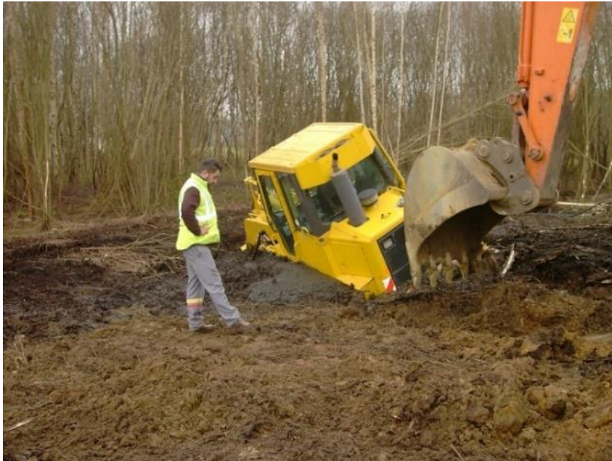
Figure1. Sol de faible portance sur chantier
